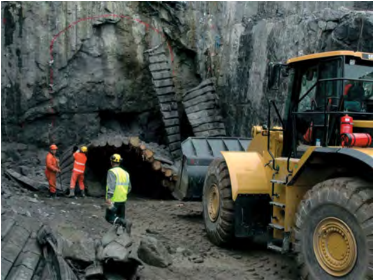
Vue du chantier du site d'Onkalo, le vrai «grand trou»
